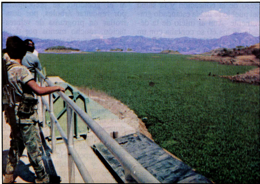
La represa "5 de Noviembre", en un paso del río Lempa completamente cubierta de plantas flotantes, sobre todo del llamado "Jacinto de Agua", lo cual acelera la disminución del caudal del río por efecto de la evapotranspiración. Es necesario limpiarla y usar la masa vegetal como forraje para el ganado, la cual también constituye materia para la producción de abono orgánico y biogás.
